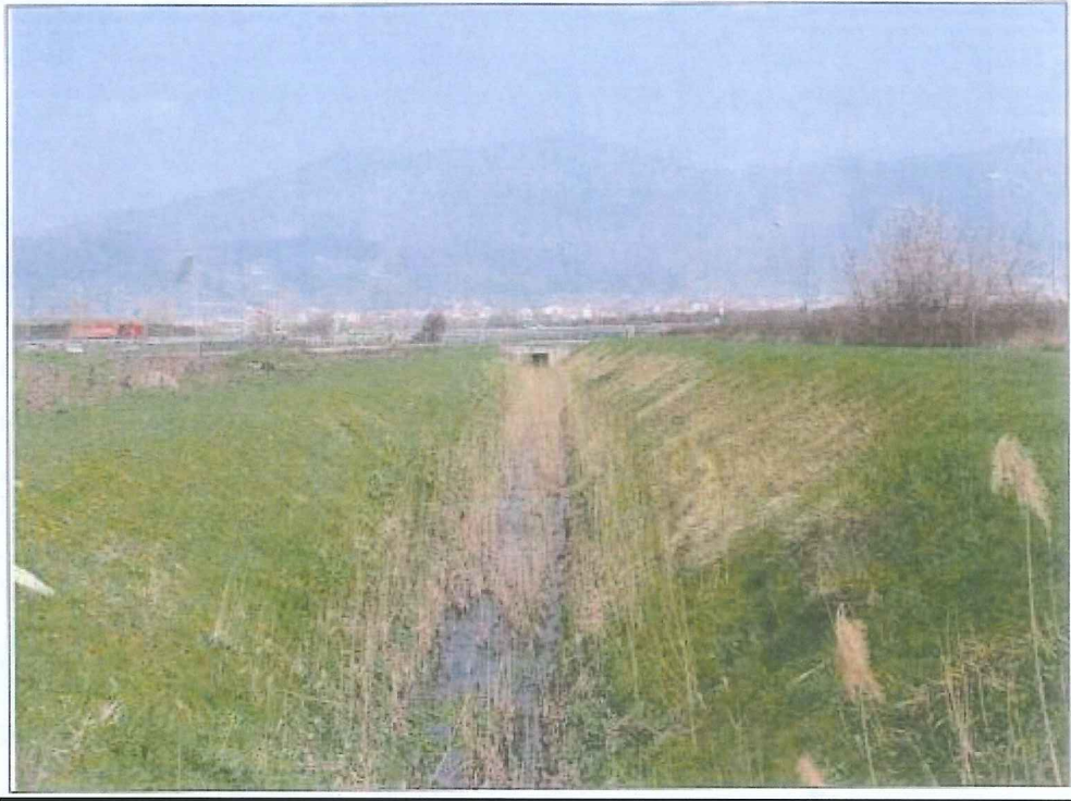
Figura 2: Canale Gavine ed attraversamento autostradale dell'A11
