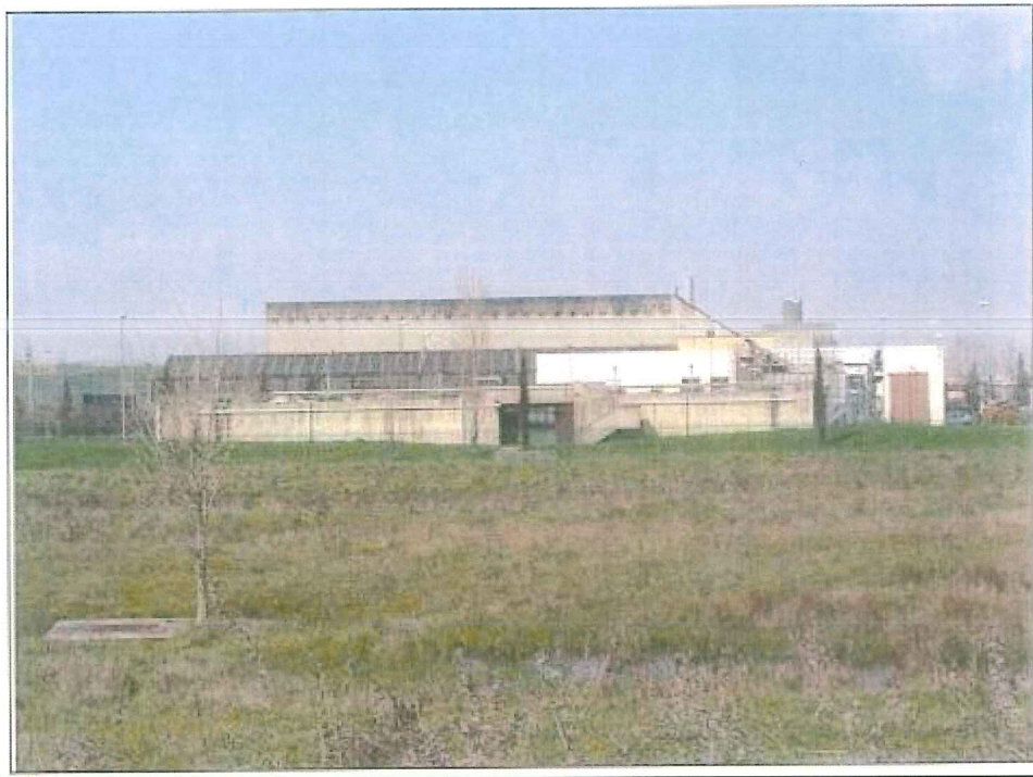
Figura 3: Vista da Est dell'impianto di selezione e compostaggio
