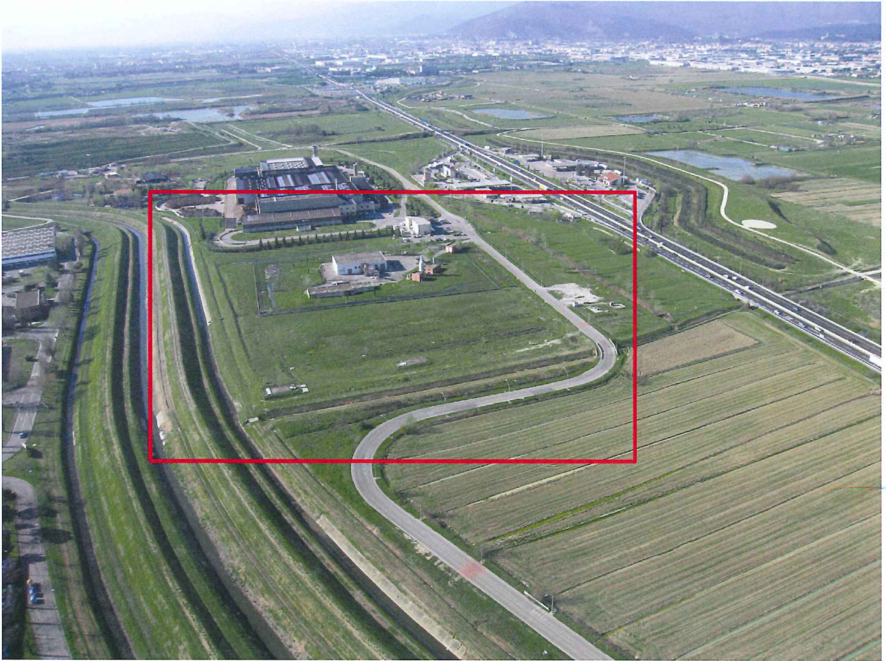
FOTO 2 - VISTA DELL'AREA DI PROGETTO DA EST VERSO OVEST – STATO ATTUALE
