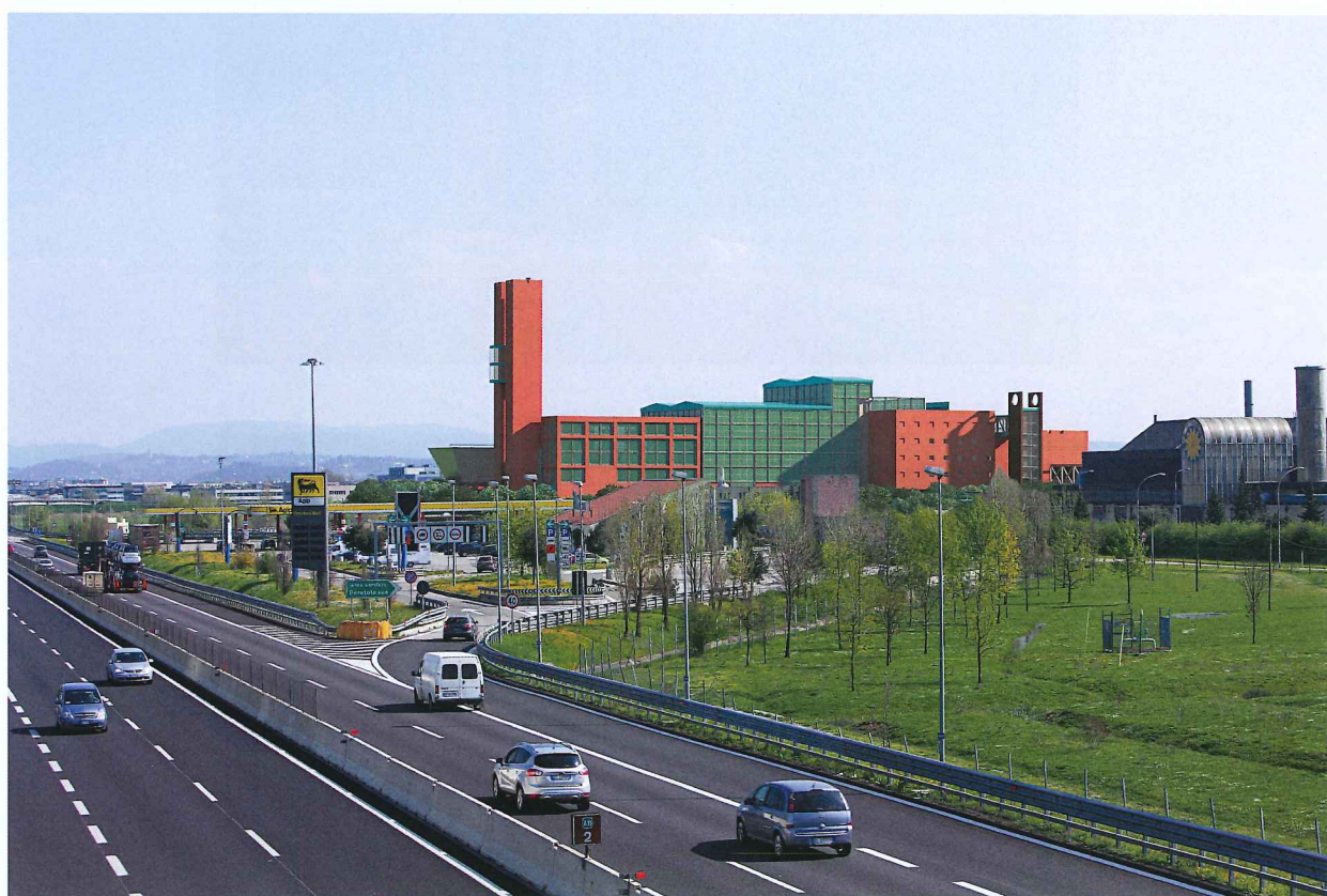
FOTOINSERIMENTO: VISTA DALL'AUTOSTRADA
